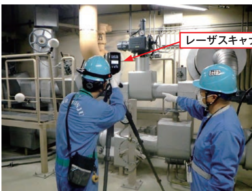
3次元レーザスキャナーによる点群データ測定の作業風景
