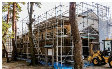
上／「水戸正士浜荷蔵へ入図」に描かれた当時の鯖蔵（天狗党騒動図より一敦賀市立博物館提供）。 下／「水戸烈士記念館（旧鯖蔵）」は現在、解体工事中。調査によって往時への復元を目指し、「史跡武田耕雲斎等墓」のある松島広場へ移築される予定。
